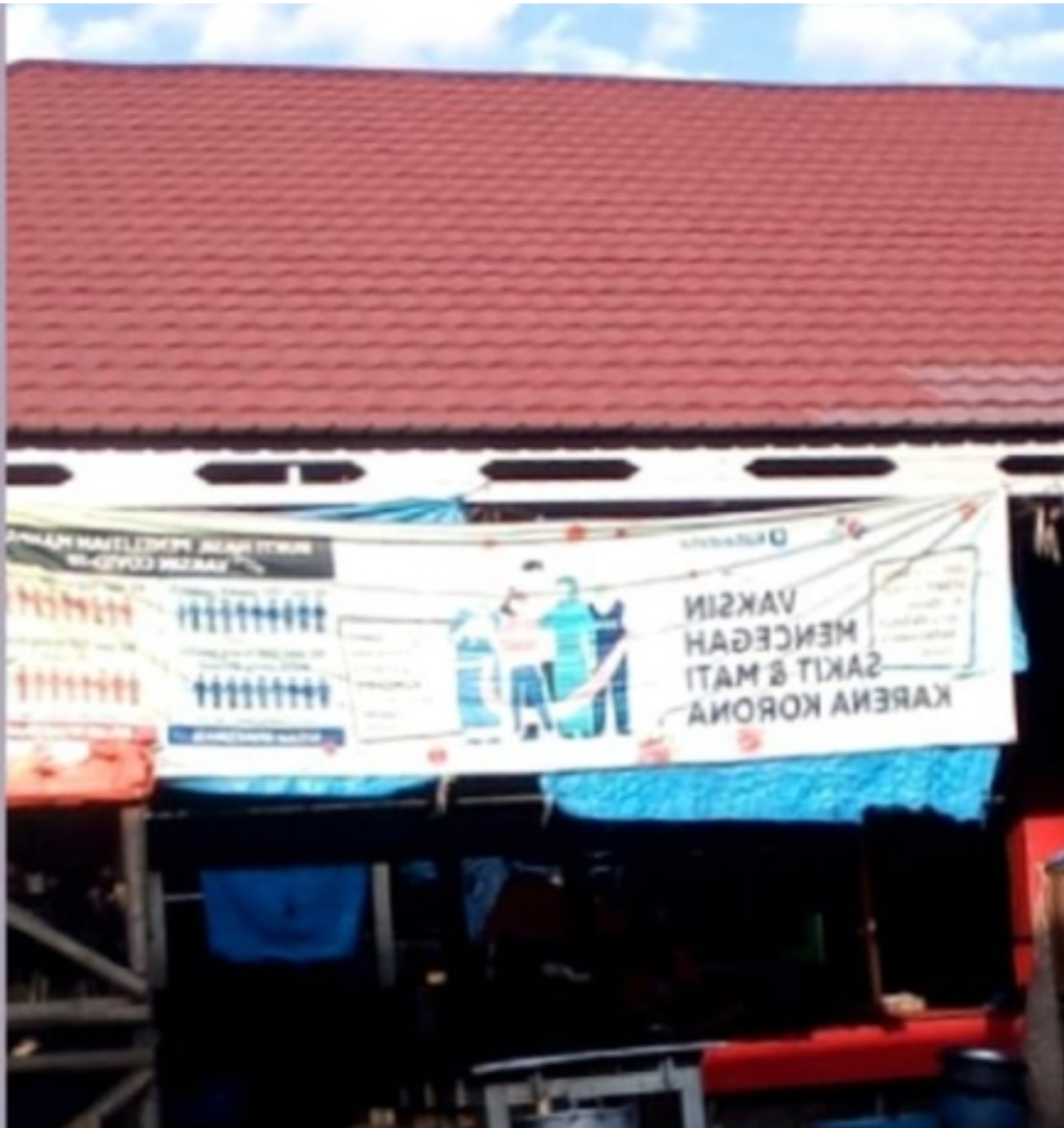
Pembangunan Pasar Sarinah Rimbo Bujang Tebo Senilai 2,2 Miliar.
